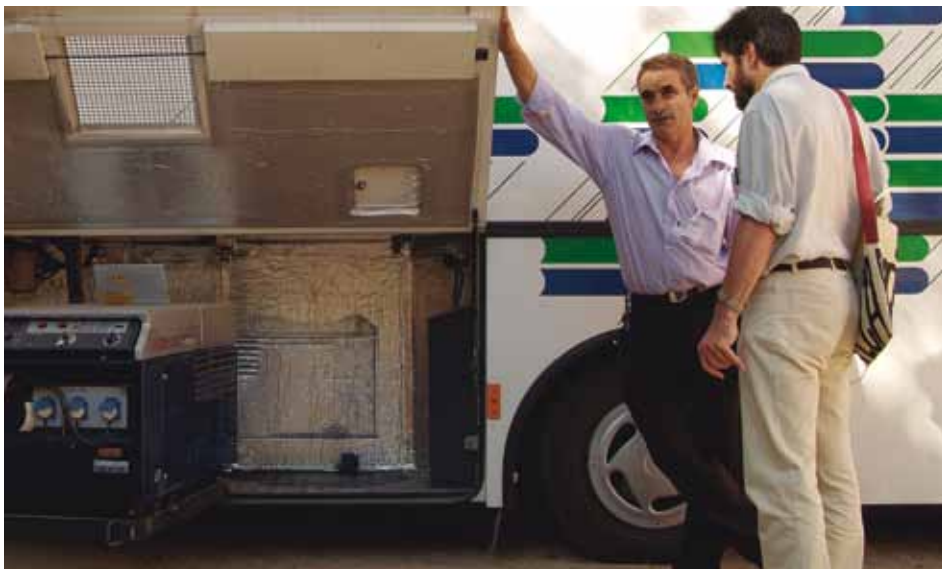
Generador autónomo a gasolina. Segovia, España.
